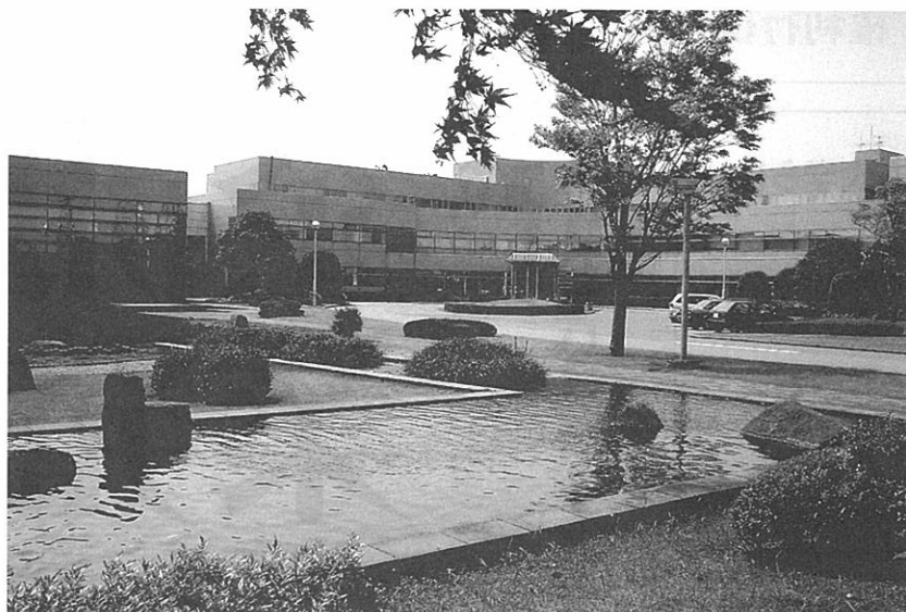
三井化学 袖ヶ浦センター
